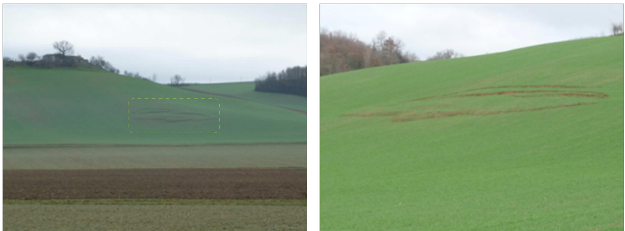
Figure 24 : Glissement superficiel à la Ritonne, observé en 2013 dans les formations argilo-gréseuses de l'Oligocène, sur la commune de CASTELSAGRAT [Source : IMS RV ]
